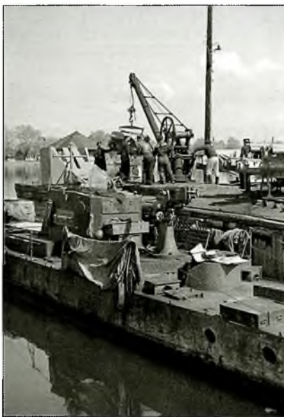
Смена моторов на бронекатере, «выходившем» моточасы, после напряженных боев. КБФ
