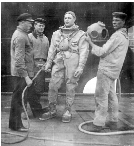
Навешивание плечевых грузов и закрепление сигнального конца 1930-е
